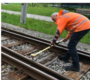
Vermessung einer Weichenprüfung
